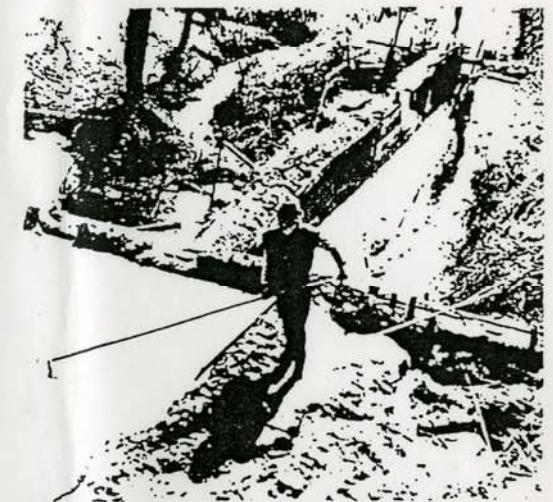
鉄穴場の本場。鉄穴場の下手にあるので下場、あるいは本場という。大池、中池、乙池、桶と順次水洗いによって砂鉄を比重選鉱する。
